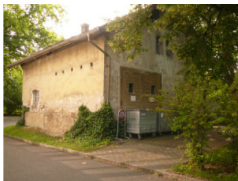
Remise vor der Renovation ....
